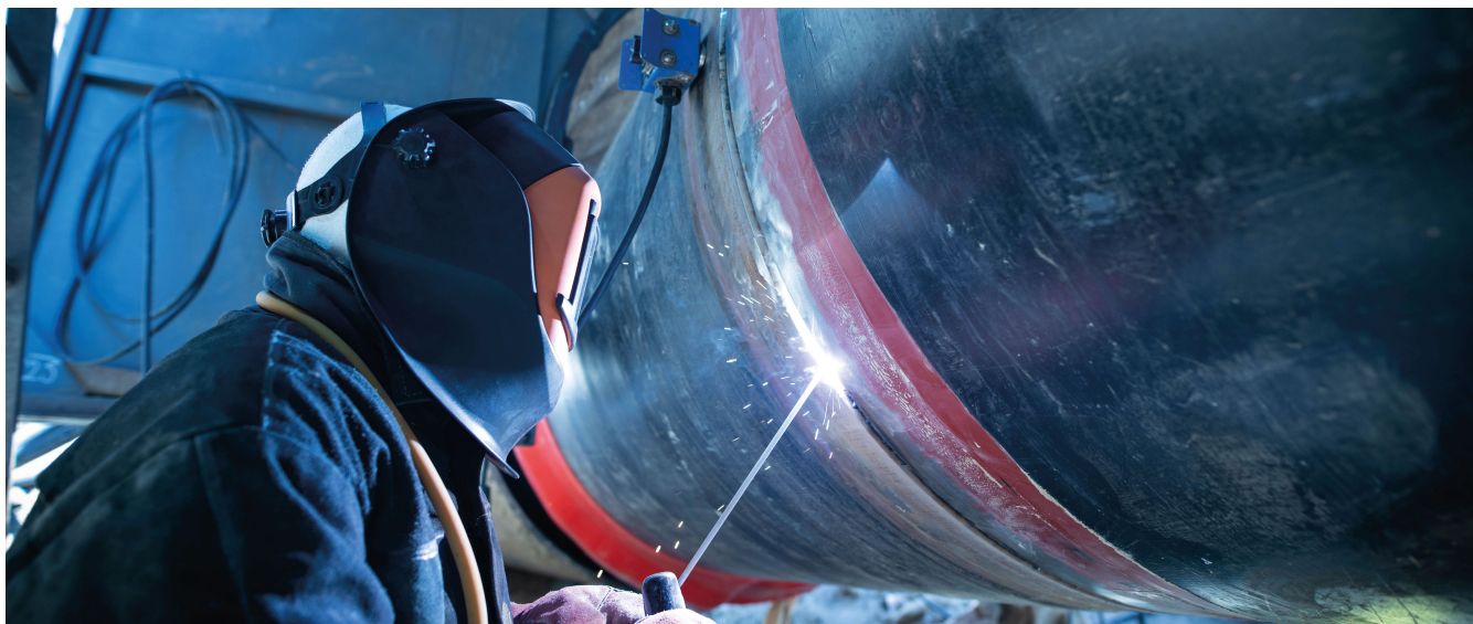
CALDERERÍA Y ESTRUCTURAS – SOLDADURA CERTIFICADA
