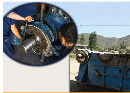
REPARACIÓN DE CHANCADOR
